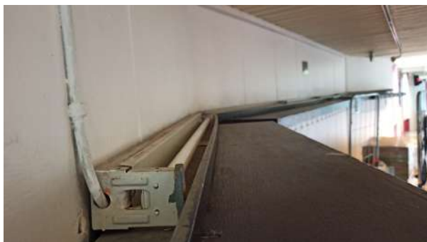
Figur 2: Lysrören vid Gatans klädhängare ersattes med balkar att installera LED-listerna på.
