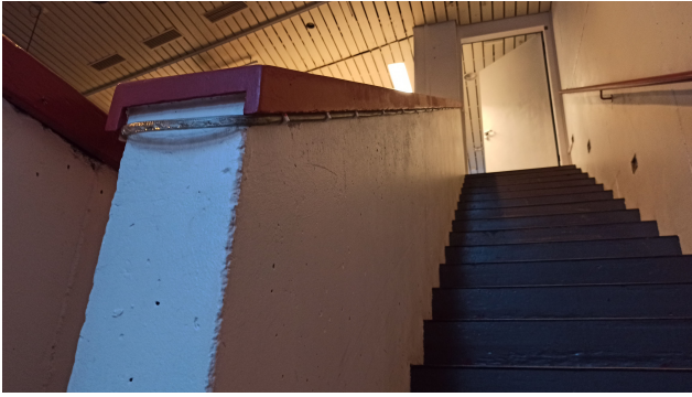
Figur 3: LED-listerna i trappan upp till Klubben skulle ersätta en söndrig ljusslinga.
